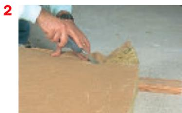
**3. Si le panneau de laine est pourvu d'un pare-vapeur, le taillader au cutter pour le rendre perméable à la vapeur.**
