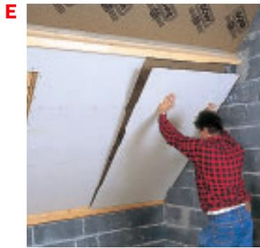
**E. Pose de plaques de plâtre sur rails, en habillage de l'isolation.**
